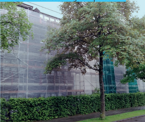
Dachdämmung in Harlaching
