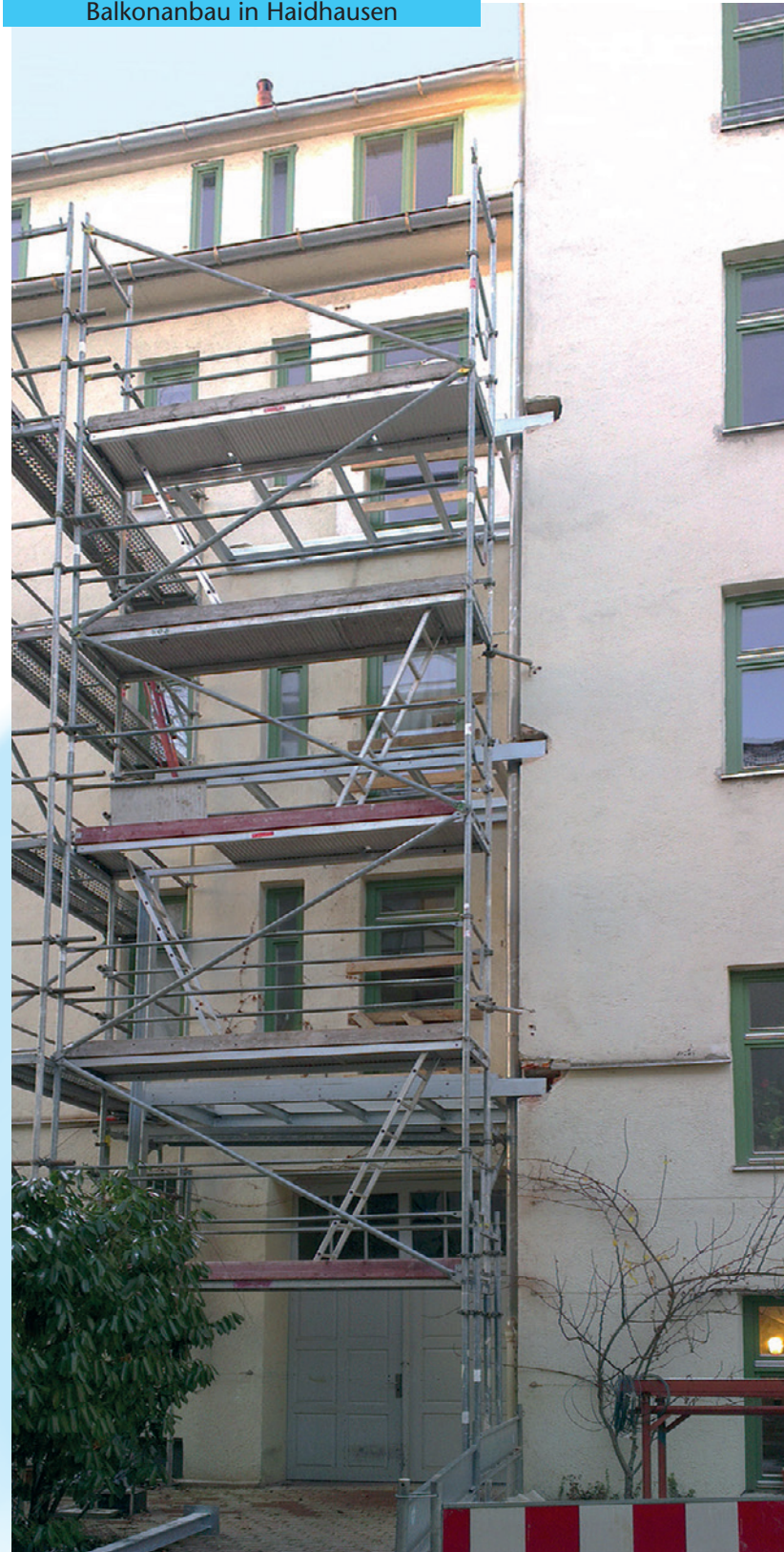
Balkonanbau in Haidhausen
